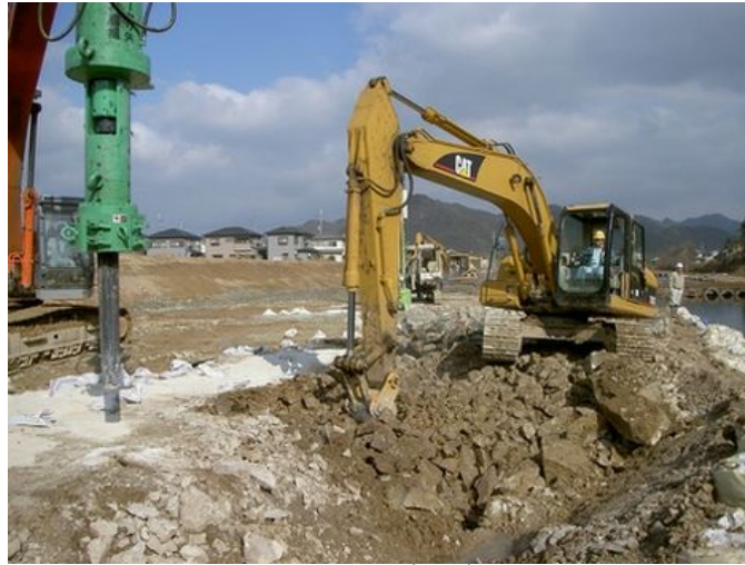
破砕岩のリッピング状況
